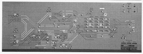
Bild 4. Gleisbildschema für die Steuerung der Beleuchtung
