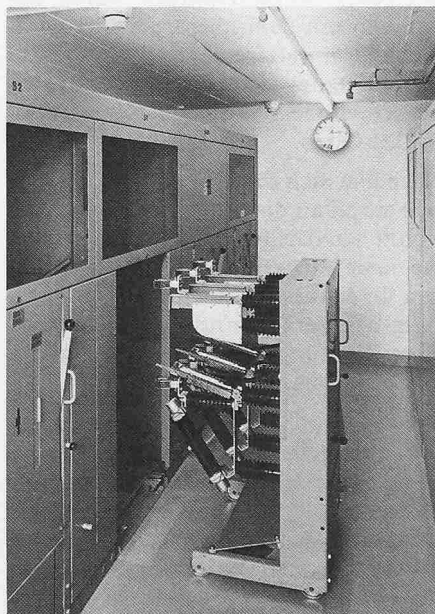
Bild 2. Detail aus Trafostation S. 16 kV Schaltfeld (links) und Transformatorzellen (rechts). An der Decke zwei Rauchgasmelder sowie eine Düse der automatischen Löschanlage mit Halongas
