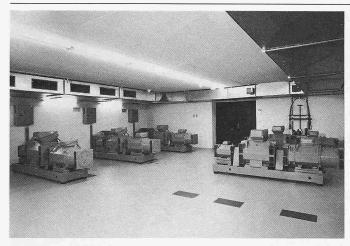
Bild 10. Umformerraum mit fünf 20-kVA-Generatoren
