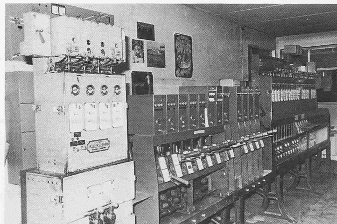
Bild 4. Stellwerk II (Signum Bauart J), mit Stationsblockeinrichtung Hasler
