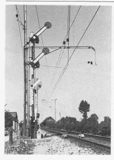
Zweiflügliges mechanisches Hauptsignal mit mechanischem Durchfahrsignal
