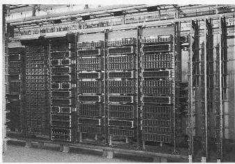
Bild 13. Stellwerk-Fernsteuerung EF 20, Seite Rothrist, für 240 Befehle und 660 Meldungen
