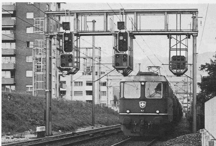
Bild 2. Elektrische Signale an Signalbrücke (Einfahrt Olten Seite Aarburg)
