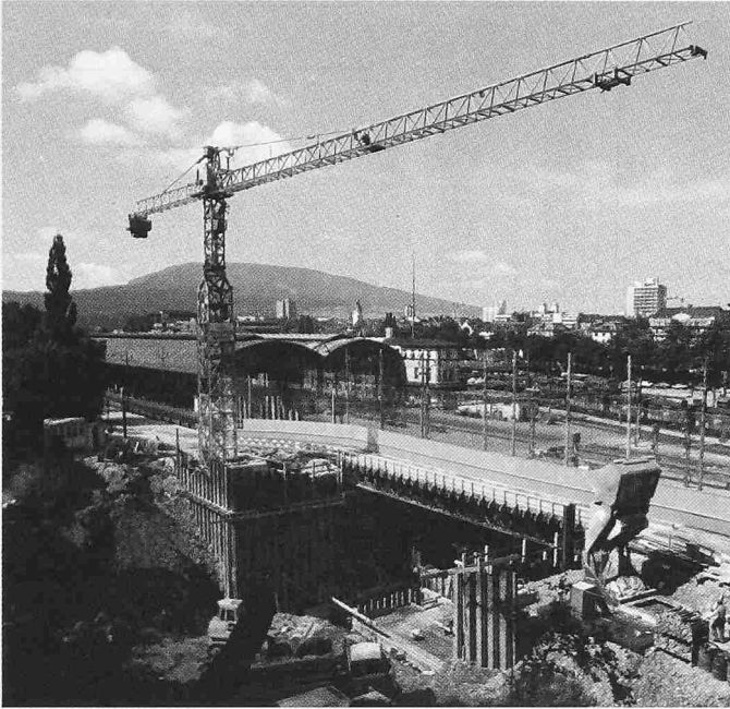
Baustelleneinrichtung mit Hilfsbrücke über Gleisanlagen als Umfassung
