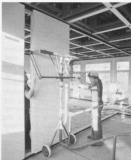
Montage der Trennwände
