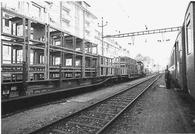
Transport der Gitterträger auf die Baustelle
