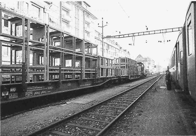
Transport der Gitterträger auf die Baustelle
