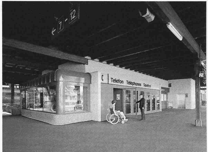
Bild 6. Olten: zentral angeordnete Telefonkabinen. Auskunftsschalter (links) und Invalidenlift zur PU-Süd (rechts)
