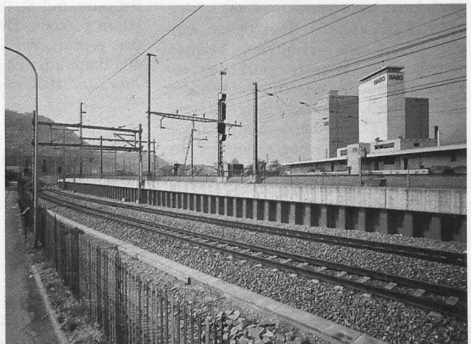
Bild 3. Überwerfung Nord, permanente Stahlspundwand an den Gleisen Olten-Basel
