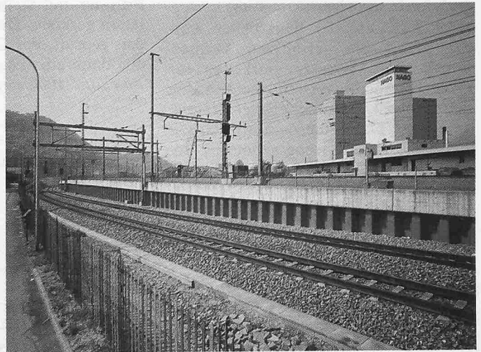
Bild 3. Überführung Nord, permanente Stahlspundwand an den Gleisen Olten-Basel
