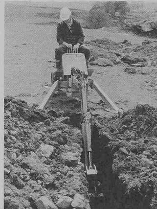
Benzinmotor betätigt den hydraulischen Antrieb.
