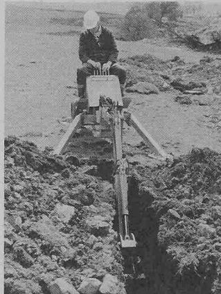
Benzinmotor betätigt den hydraulischen Antrieb.
