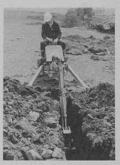
Benzinmotor betätigt den hydraulischen Antrieb.
