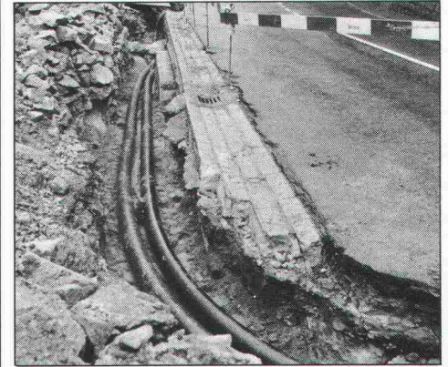
11.55 Komplett verlegt – 360 m nahtlose Fernwärmeleitung – Ziel erreicht!
