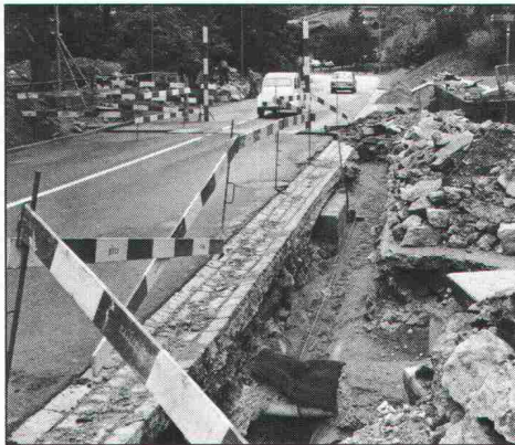
09.57 Das Zugseil ist in den Graben eingelegt...
