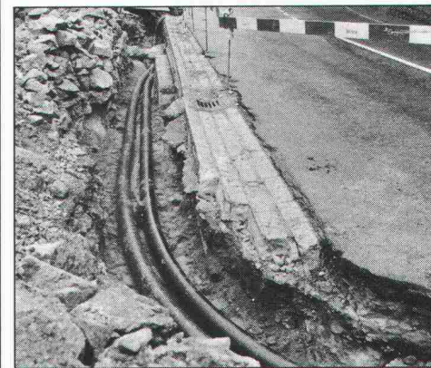
11.55 Komplett verlegt – 360 m nahtlose Fernwärmeleitung – Ziel erreicht!
