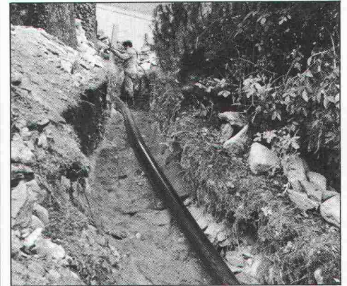
10.45 Die erste Länge ist verlegt...
