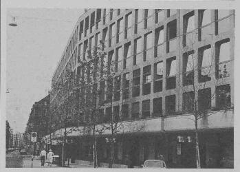
Verwaltungsgebäude der Kreistelefondirektion Zürich. Fassade aus Aluminium-Herdgussplatten
