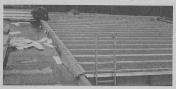
DLW-Dachelemente Typ T 90/75 als Verwendung für Flachdachkonstruktion
