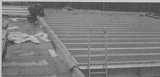
DLW-Dachelemente Typ T 90/75 als Verwendung für Flachdachkonstruktion
