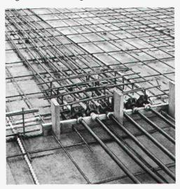
Ende eines Betonierabschnittes mit Zwischenabspannstelle der Spannkabel.
