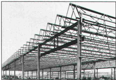
Metallstruktur eines Fabrikgebäudes mit Mini-Sheddach
