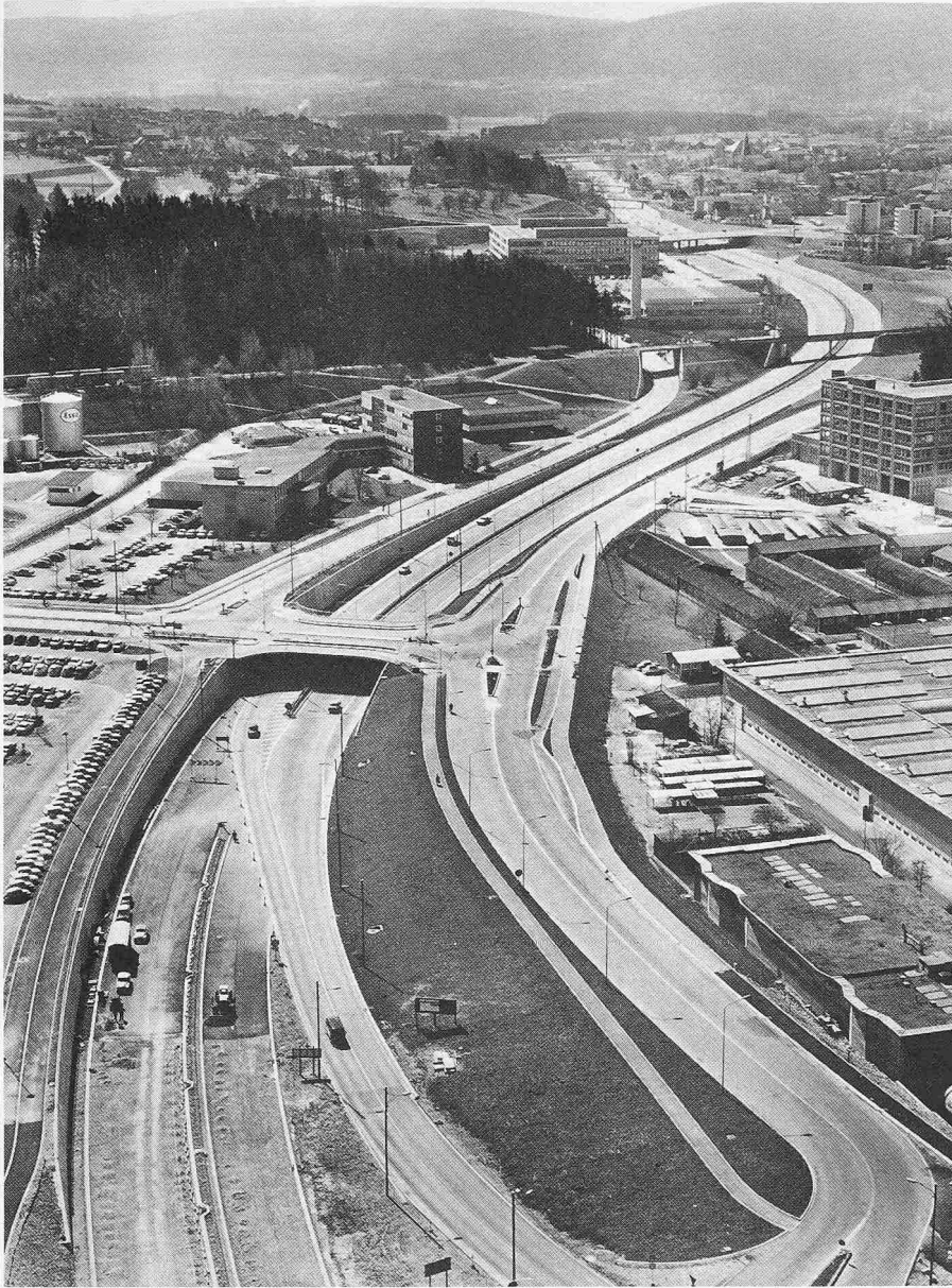
Die Strasse wird zur Planungseinheit: Kloten. Comet-Luftaufnahme
