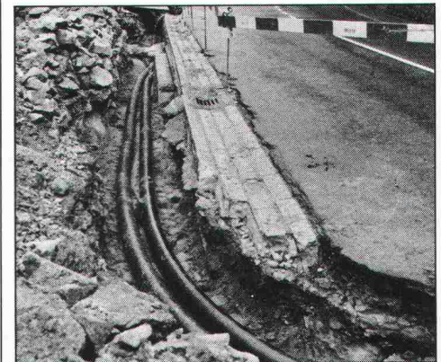
11.55 Komplett verlegt – 360 m nahtlose Fernwärmeleitung – Ziel erreicht!
