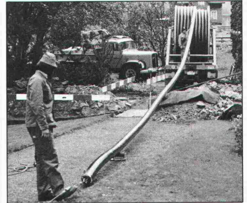
10.04 Die Verlegung der FLEXWELL-Leitung beginnt...
