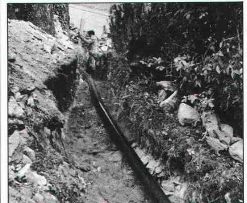
10.45 Die erste Länge ist verlegt...
