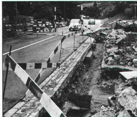
09.57 Das Zugseil ist in den Graben eingelegt...
