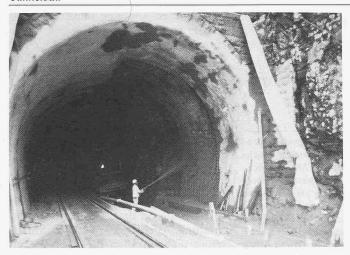
Auftragen des Spritzbetons. Man erkennt die verschiedenen Spritzbetonlagen, die eingebauten Armierungen, ferner die senkrecht nach unten verlaufenden Halbschalen-Drainageleitungen
