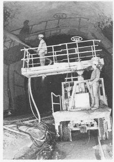
Gespritzt wurde von einem mobilen Gerüst aus mit einer Mischung, bestehend aus 425 kg Hochofenschlackenzement auf 10001 Sand 0-8 mm. Die Verwendung von Hochofenschlackenzement (75% gemahlene Hochofenschlacke + 25% Portlandzement) war vorgeschrieben. Da verschiedentlich gegen Wasserandrang gekämpft werden musste, wurden je nach Erfordernis Schnellbinder zugegeben. Der «Guniteur» an der Spritzdüse steuerte den Nachschub an Spritzmörtel, Wasser und evtl. Schnellbinder von der Düse aus
