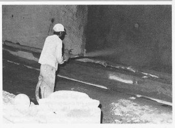
Bild 7. Um das Aussehen zu verbessern, wurde als letzter Auftrag ein 5 cm starker Feingunit, bestehend aus einer Mischung von 1000 l 0-4 mm auf 450 kg Bindemittel, aufgetragen. Diese letzte Schicht dient gleichzeitig auch der Verbesserung der Dichtungswirkung
