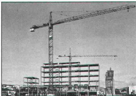
Stahlkonstruktion eines mehrgeschossigen Schulgebäudes
