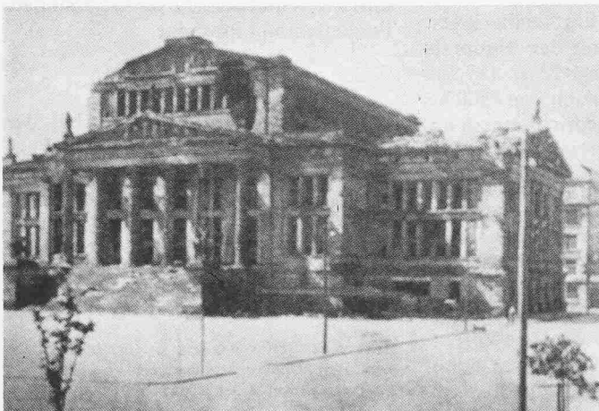
Das zerstörte Schauspielhaus vor Beginn des Wiederaufbaus
