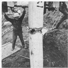
Das Dyn-a-splice-Pfahlverbindungssystem ist bereits in 45 Ländern patentrechtlich geschützt und weltweit über Lizenzverträge vertrieben worden. Die Länge der Pfahlschüsse beträgt normalerweise bis zu 13 m und gestattet damit einen wirtschaftlichen Transport auf herkömmlichen 12-m-Tiefladern.
