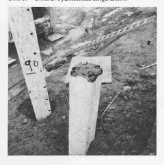
Bild 7. Aufsetzen des oberen Pfahlschusses
