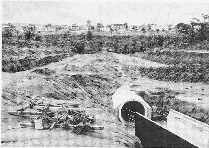
Bild 18. Hauptsammelleitung in Neu-Owerri
