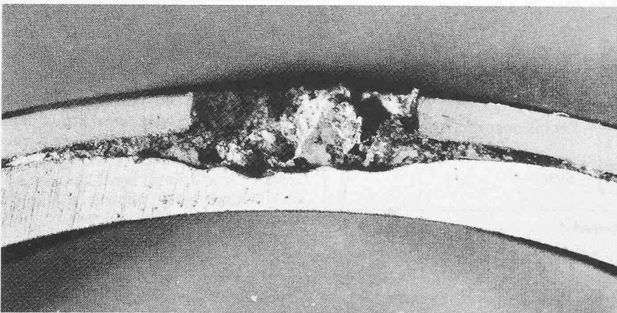
Bild 14. Korrosionsangriff, ausgelöst durch chloridhaltige Eluate aus Müllschlacke (nach [3])
