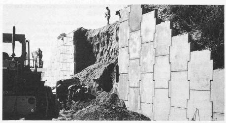
Versuchsbauwerk aus bewehrter Erde. Die speziell dünne Bewehrung wurde für eine Lebensdauer von 8 Monaten ausgelegt. Nach 9 Monaten ist das Bauwerk zusammengebrochen
