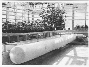
Gewächshauskabine mit Heizverteiler, Luftverteilsystem, Zusatzbeleuchtung, Schattierungssystem (Sonnenkollektoren)
