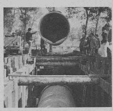
Die Elemente sind mit einer Druchlaufrinne, bestehend aus Drittelschalen und Eterplacplatten, ausge-
