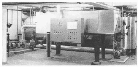
Bild 2. Umgebaute Vorpasteurisierungsanlage mit Wärmerückgewinnung
