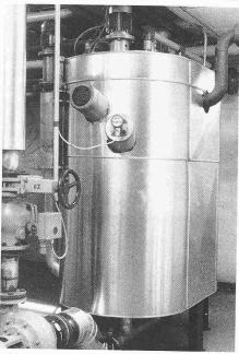
Bild 1. Sulzer Schlamm/Schlamm-Wärmetauscher
