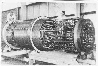
Bild 5. Einrohr-Zwangdurchlauf-Dampferzeuger
