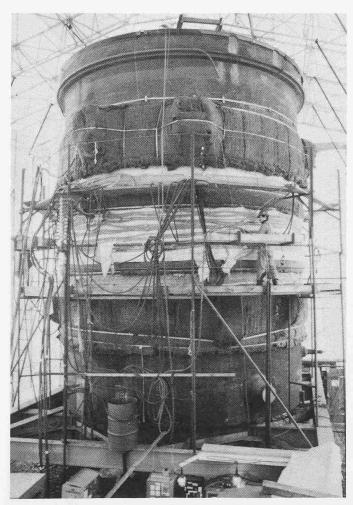
Baustellenschweissung eines GE-BWR-Druckgefässes in Leibstadt/CH mit vier Rundnähten von 152 mm Dicke und 6100 mm Durchmesser
