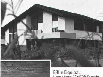
Vorgehängte CEMFOR-Fassade Modell: **CEMFOR-HOLZBRETT** Architekt: Remo Sieber, Diepoldsau
