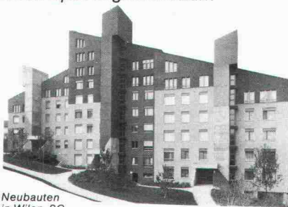
Neubauten in Wilen, SG. Überbauung mit Holz/IV-Fenstern.
