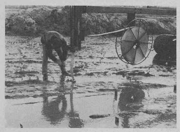
Das «Mebra-Drain» wird mit einer besonders entwickelten Vibrations-Ramme in den Boden getrieben.
