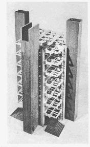
Richard Medical-Towers. Aufbau eines Laborturmes. Die Versorgung und Entsorgung eines Turmes erfolgt in den Vertikal-Schächten und den horizontalen, raumhaltigen Geschossträgern
