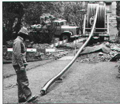
10.04 Die Verlegung der FLEXWELL-Leitung beginnt...
