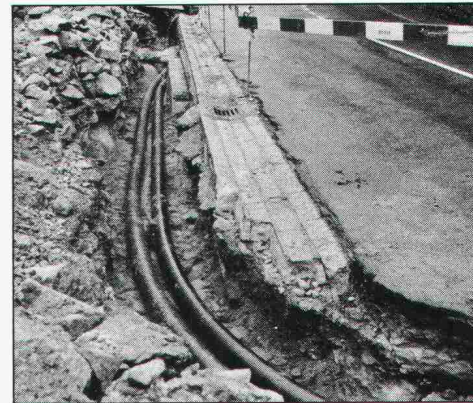
11.55 Komplett verlegt – 360 m nahtlose Fernwärmeleitung – Ziel erreicht!
