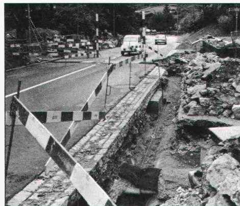
09.57 Das Zugseil ist in den Graben eingelegt...
