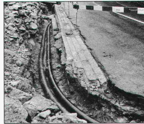
11.55 Komplett verlegt – 360 m nahtlose Fernwärmeleitung – Ziel erreicht!
