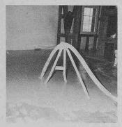
Caloflex-Compact, die Fussbodenhei-zung für die Altbaurenovation: Der flüssige Renoplanit®-Unterlagsboden wird über eine Schlauchleitung auf die Heizfläche gepumpt. 48 Stunden später ist er bereits voll belastbar.
