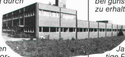
Industriebau in Liestal, BL. Neubau mit Kunststoff-Fenstern.
