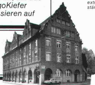
Verwaltungsgebäude in Winterthur, ZH. Altbau renoviert mit Kunststoff-Fenstern und Isolierverglasung.
