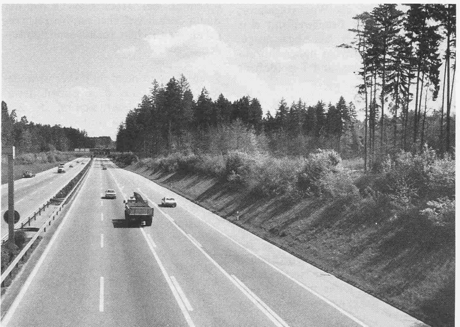
Wird geschlossener Wald aufgerissen, treten leicht Windwurfschäden auf. Mit der Zeit fressen sie sich unaufhaltsam in die angrenzenden Waldungen hinein
