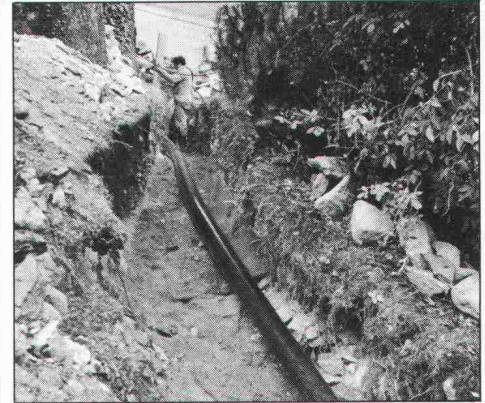
10.45 Die erste Länge ist verlegt...
