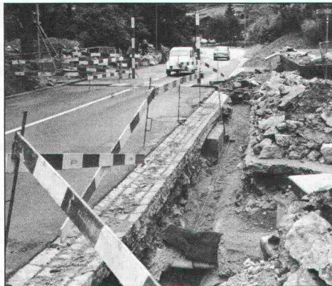
09.57 Das Zugseil ist in den Graben eingelegt...
