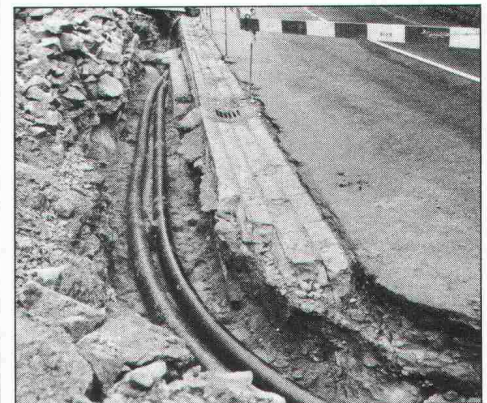
11.55 Komplett verlegt – 360 m nahtlose Fernwärmeleitung – Ziel erreicht!
