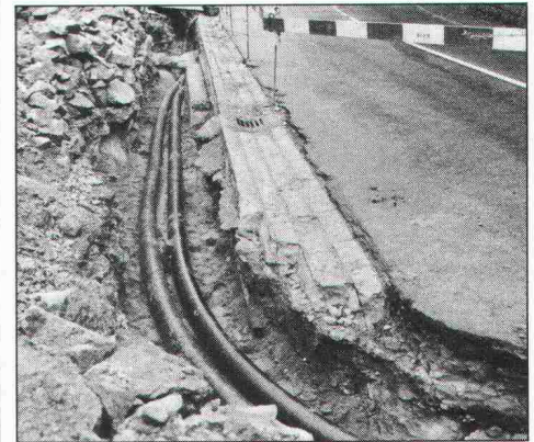
11.55 Komplett verlegt – 360 m nahtlose Fernwärmeleitung – Ziel erreicht!
