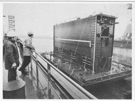
Kürzlich wurde das erste Stahlschiebetor für das Aussenhaupt der im Umbau befindlichen Bremer Industriehafenschleuse fertiggestellt. Das Bild zeigt den auf einem Ponton stehenden Koloss, bevor er zu Wasser gelassen und aufrecht schwimmend von Schleppern zum Schleusenhaupt bugsiert wurde
