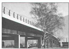
Strassenbrücke in Verbundbauweise Stahl/Beton
