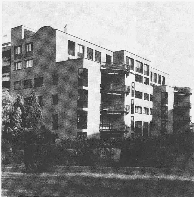
Ansicht des «Anbaus» von Westen
