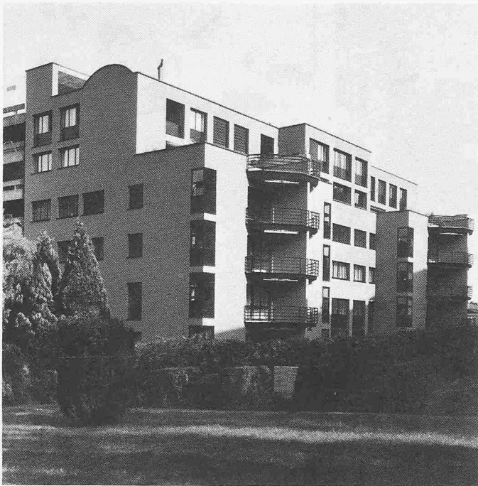
Ansicht des «Anbaus» von Westen
