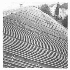
Niedertemperaturkollektoren (Kunststoffrohre, gefüllt mit Wasser) nutzen die ganze Oberfläche: Ener-
