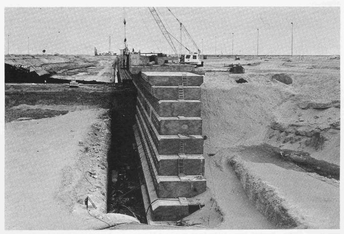
Bild 18. Hafenmauer Jebel Ali. Total 1,5 Mio. m³ Beton
