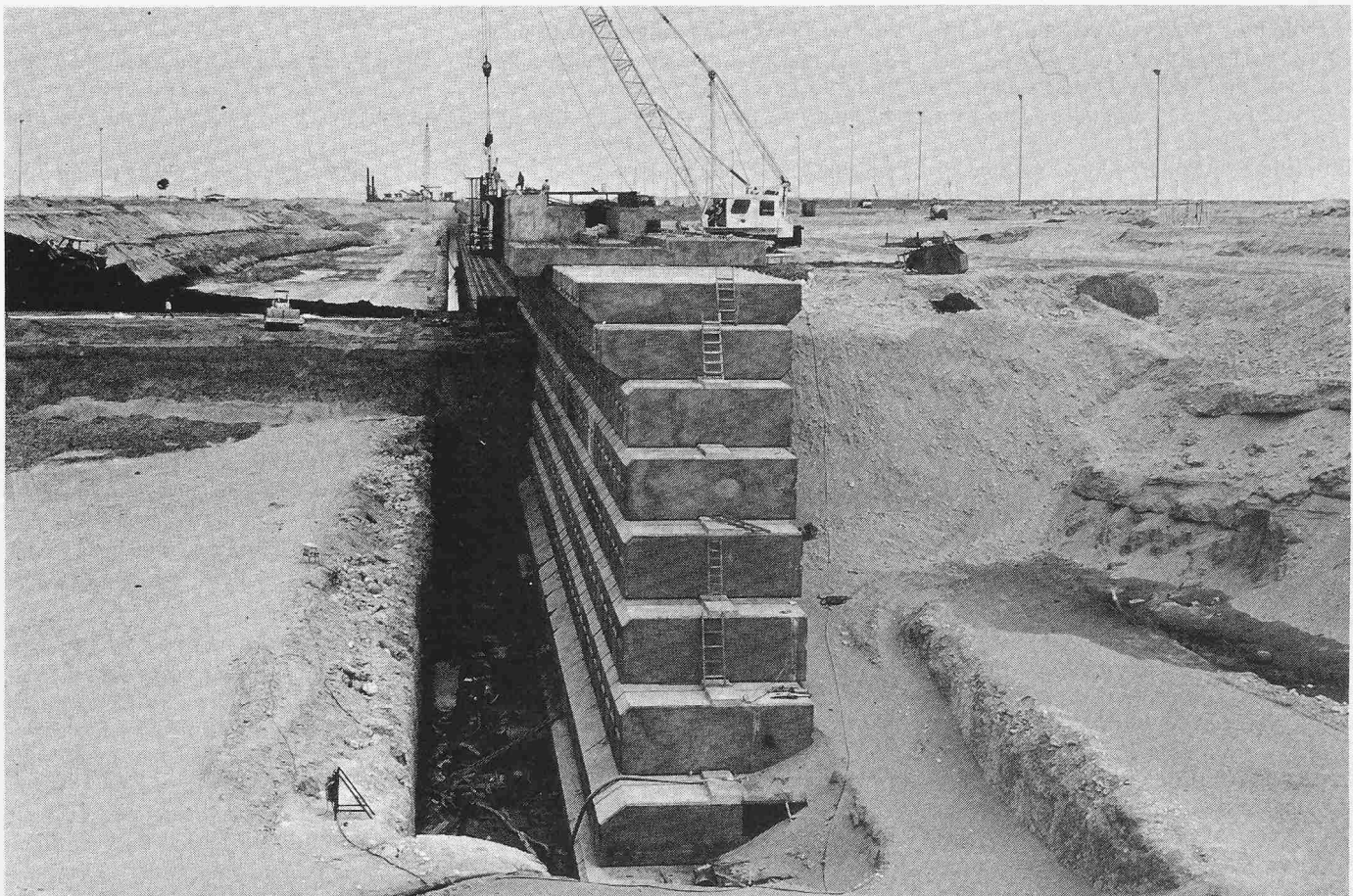
Bild 18. Hafenanlage Jebel Ali. Total 1,5 Mio. m³ Beton
