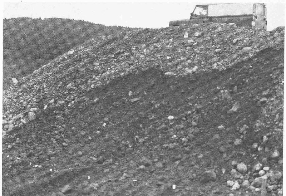
Bild 5. Hang nach der zweiten Hangfussentlastung
