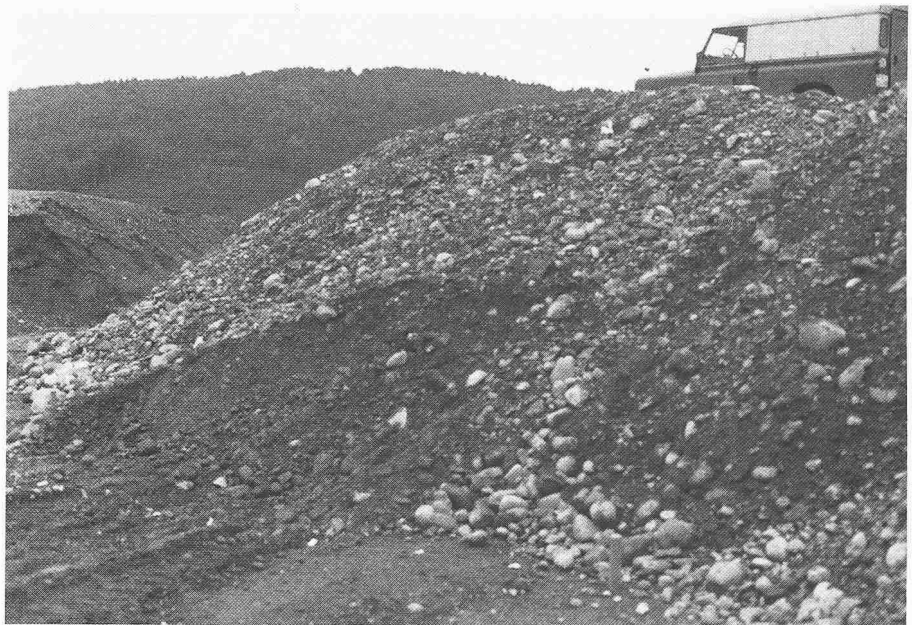
Bild 4. Hang nach Entnahme der ersten zwei Trax-Schaufeln
