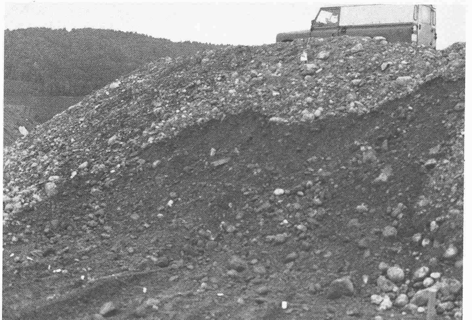
Bild 5. Hang nach der zweiten Hangfussentlastung
