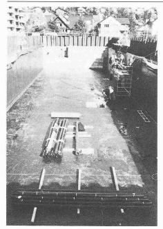
Geschlossene Baugrube und Innenabdichtung beim Oberstufenschulhaus Horw. Verlegen von vorkonfektionierten Abdichtungsplanen auf die äussere Wanne, 2-Lagen-Prüfsystem.
