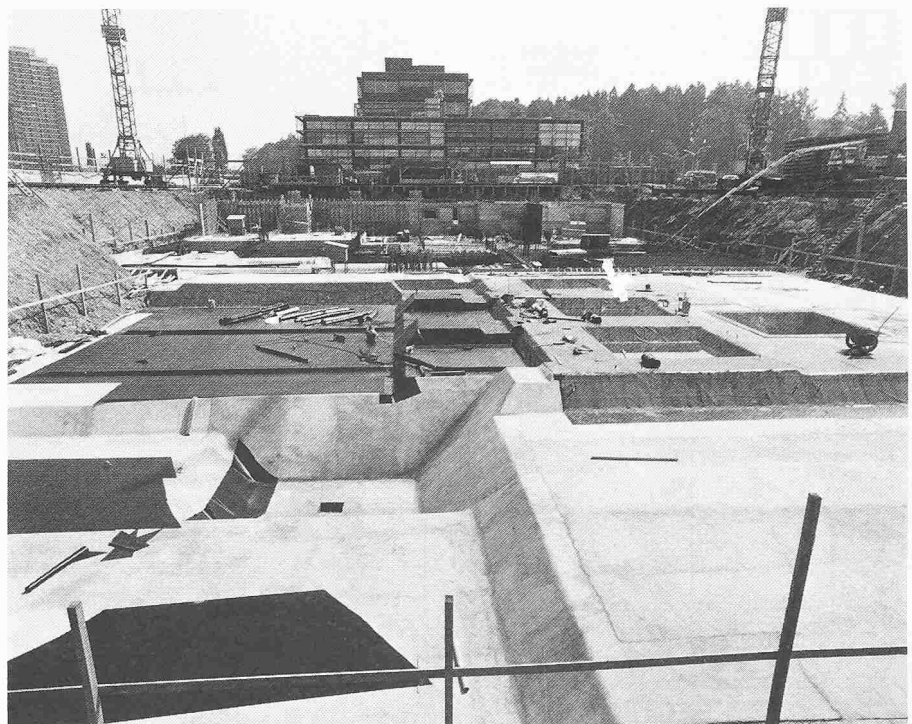
Offene Baugrube und Aussenabdichtung bei der Volksbank Bern, 2-Lagen-Prüfsystem; von unten nach oben: Unterlagsboden mit Zementglattstrich, Verlegen der Abdichtungen, Schutzschicht, Armierung, Bodenplatte, aufgehende Wände
