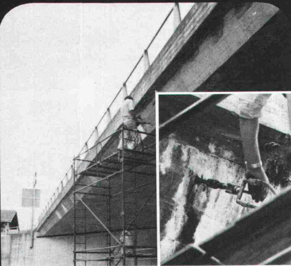
Risse in Betonbauwerken Abdichtung mit Renesco- Flexin-Injektionen
