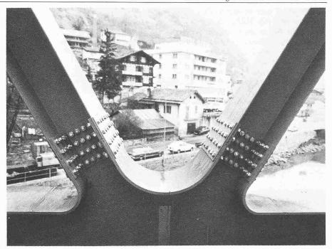
Bild 3. Anschluss der Streben an den Untergurt
