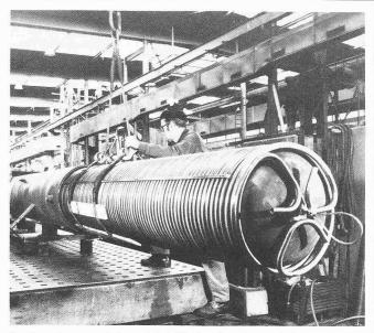
Das Dampferzeuger-Rohrbündel wird in den Mantel eingeschoben
