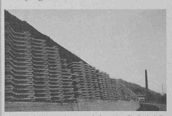
Eine bestehende Schwergewichtsmauer an der Staatsstrasse Oberdiessbach-Konolfingen wird mit Sternelementen um etwa 3 m erhöht (Februar 1980). Zwischenraum der Elemente C bzw. 26 cm, Neigung 5:1, Ausbildung von Nischen
