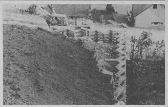
Gartengestaltung mit Sternelementen. Das dreischenklige Element wiegt 50 kg, das zweischenklige Element, das hier für den Abschluss der Mauer verwendet wurde, wiegt 35 kg je Stück
