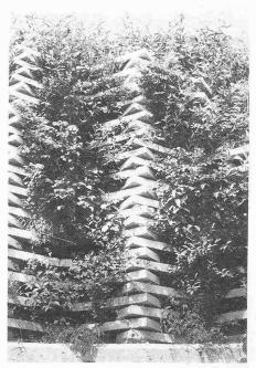
Bild 4. Sternelementmauer mit Heckenbuschlagen
