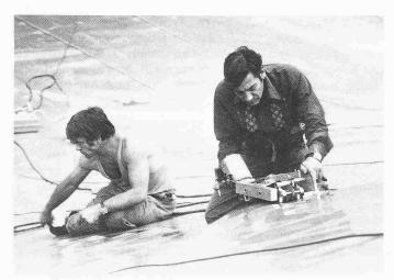
Bild 7. Verschweissungsarbeiten zwischen zwei verlegten Bahnen mit dem Doppelheizkeilschweissapparat, mit dem zwei parallele Schweissnähte erzeugt werden. Der dazwischenliegende Hohlraum dient der Prüfung der verlegten KDB
