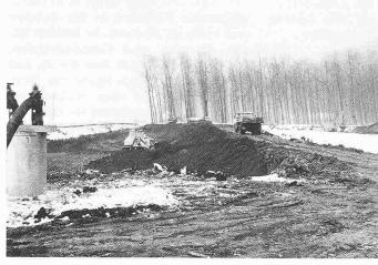
Fundationsarbeiten in der zukünftigen gesicherten Deponie in Collombey-Muraz. Vor dem Einbau der verschiedenen Dichtungsschichten musste der Boden durch eine Grundwasserabsenkung stabilisiert werden
