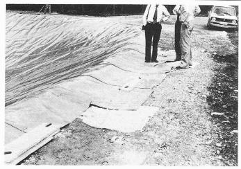
Auf der Dammkrone werden die verlegten Kunststoffdichtungsbahnen behelfsmässig mit vernagelten Brettern fixiert
