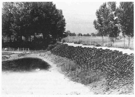
Bild 1. Blick auf die Pilotanlage auf dem Areal der Ciba-Geigy AG in Monthey. Die Böschungen wurden etwas zu steil ausgeführt. Um ihr Abrutschen zu verhindern, wurde die auf den Böschungen verlegte KDB aus Hochdruckpolyäthylen mit alten Autoreifen beschwert
