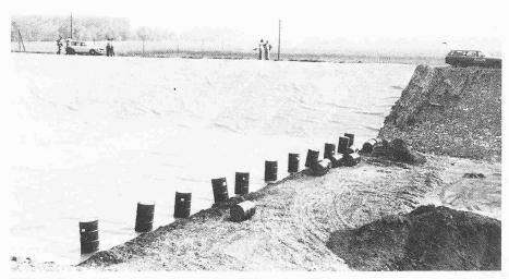
Blick auf die verlegte und verschweisste KDB aus Sarnafil FP, einer 2 mm starkem grün durchgefärbten Kunststoffdichtungsbahn aus Hochdruckpolyäthylen, fertig verschweisst. Die Fässer im Vordergrund dienen der Beschwerung der KDB der ersten Etappe
