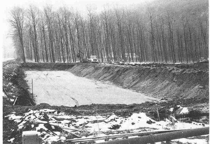
Bild 3. Das Becken für die gesicherte Deponie ist teilweise ausgehoben
