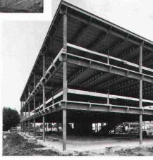
200 Vollstahlstützen für die BIZ
