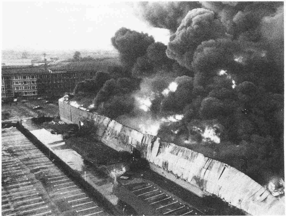
Am Donnerstag, dem 20. Oktober 1977, wurde das zentrale Ersatzteillager der Ford-Werke AG in Köln-Merkenich durch Feuer vollständig vernichtet
