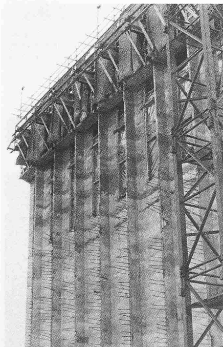
Anschluss-Seite zweite Bauetappe mit Zellenwandanschlüssen
