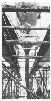
Uddemann-Gleitbühne mit Beschickungsaufbau für das Einbringen des Fliessbetons (links), welcher über Krankübel mit Hilfe eines Trichters auf Rollwagen und mit beweglichem Gummischlauch in die zu betonierenden Zellenwände erfolgte. Rechts: Fliessbeton-Beschickungsvorrichtung
