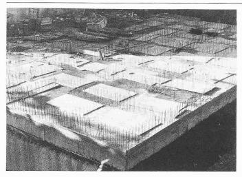
Decke über UG mit einbetonierten Zellenausläufen, hergestellt mit Fliessbeton
