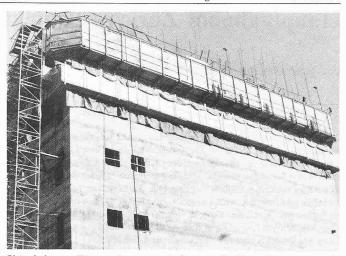
Gleitschalung - Hängegerüst aussen, isoliert mit Guritherm-Betonmatten, als Nachbehandlung des Betons
