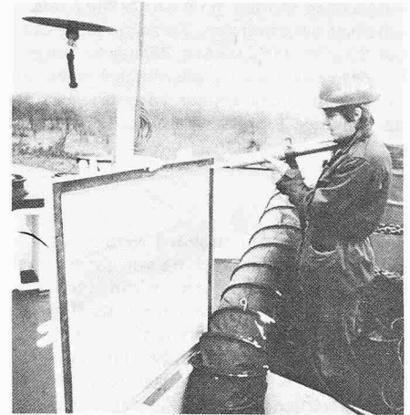
Dichtung einer Fuge zwischen Stahl und eingeletem elastischem Profil. Der PUR-Kitt wird nicht nur als elastische Dichtung, sondern auch für die Verklebung und Versiegelung in Industrie und Gewerbe verwendet
