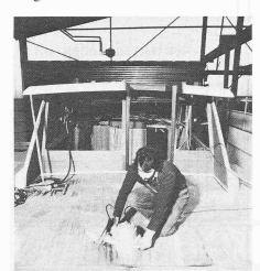
Die Fugen zwischen den Riemen eines hölzernen Deckes einer Yacht wurden mit Polyurethan-Kunststoffkitt gedichtet. Anschliessend wurde die Deckfläche noch mit der Schleifscheibe bearbeitet. Trotz der harten Beanspruchung wurde der Kitt nicht aus den Fugen zwischen den Decksplanken herausgerissen und die Schleifscheibe wurde auch nicht verschmiert
