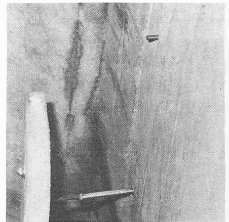
Bild 3. Verkleidungsplatten. Die Tunnelverkleidung aus vorfabrizierten Betonelementen wurde unten abgestellt und oben dann mit zwei speziellen Halteplatten und Klebeankern aus rostfreiem Stahl fixiert
