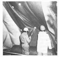
Bild 6. Bohren eines zusätzlichen Befestigungspunktes an der Nahtstelle der PVC-Folie
