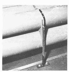
Bild 2. Versorgungsleitungen. Schutzrohrbefestigung für Licht- und Steuerleitungen, die mit Aussengewindedübeln befestigt werden
