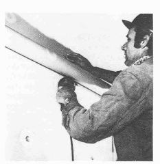
Bild 10. Die Folie wird mit Heissluft auf den PVC-Teller geschweisst
