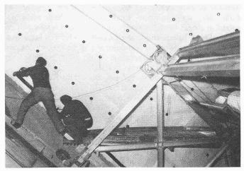
Bild 5. Spezialgerüst im Schrägschacht Bäzberg. Befestigt und gesichert mit vier Drahtseilen, die mittels Felsanker im Granit verankert sind
